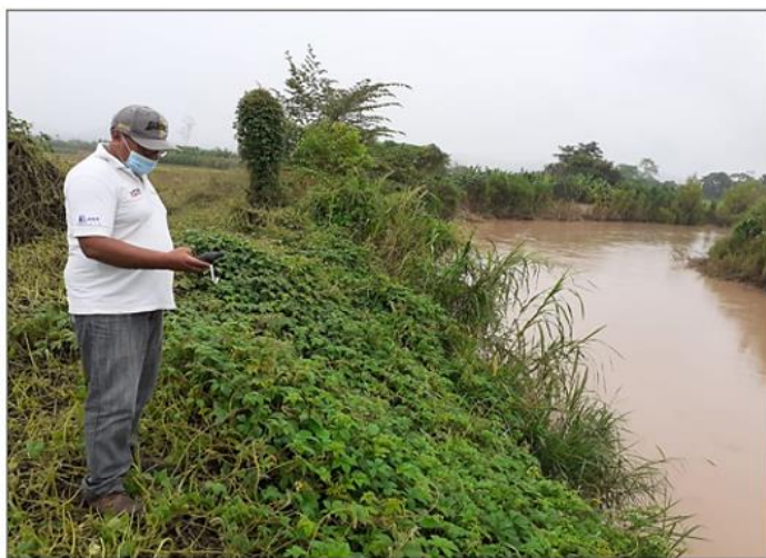
FIGURA N°03: TRAMO EN EL QUE EL CANAL DE RIEGO SE ENCUENTRA CERCA DEL RIO, Y ESTA PROPENSO A COLAPSAR POR LAS CONSTANTES INUNDACIONES.
